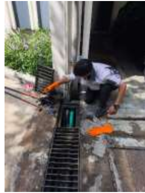
รูปที่ 39 ทำความสะอาดรางระบายน้ำ
